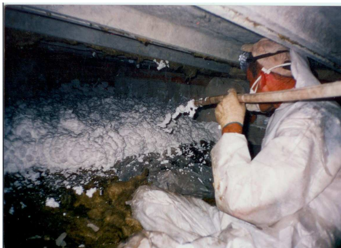
Rysunek 14. Natrysk stropodachu pianką krylaminową.
